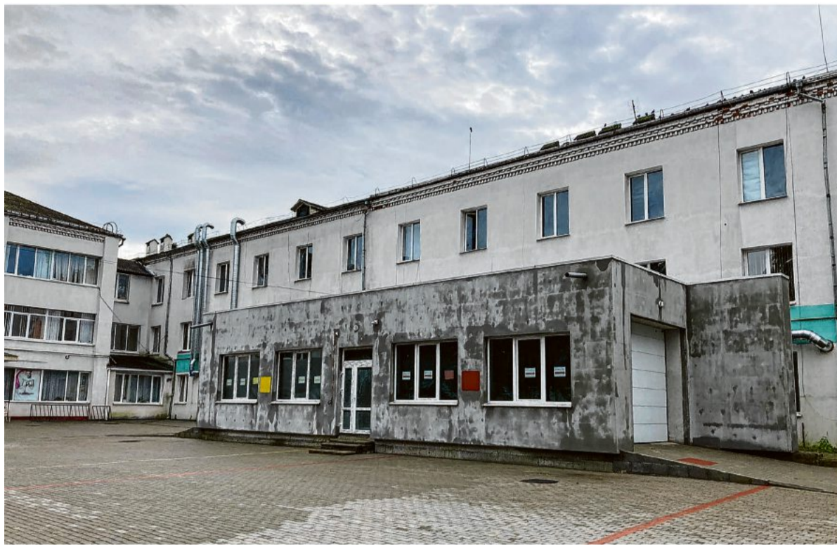
Trotz des Krieges können auch weiterhin notwendige Infrastrukturprojekte umgesetzt werden: Für die Klinik von Starokostjantyniv wurde eine Liegendkrankenzufahrt gebaut. Fotos: Privat
